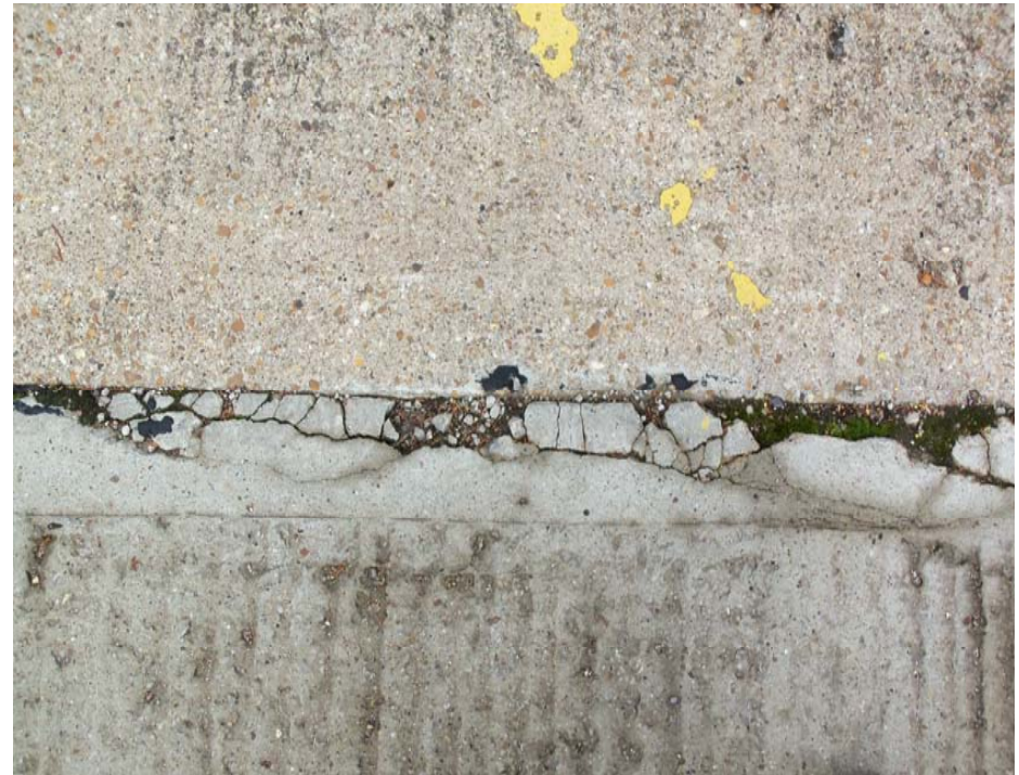
Edge cracking
